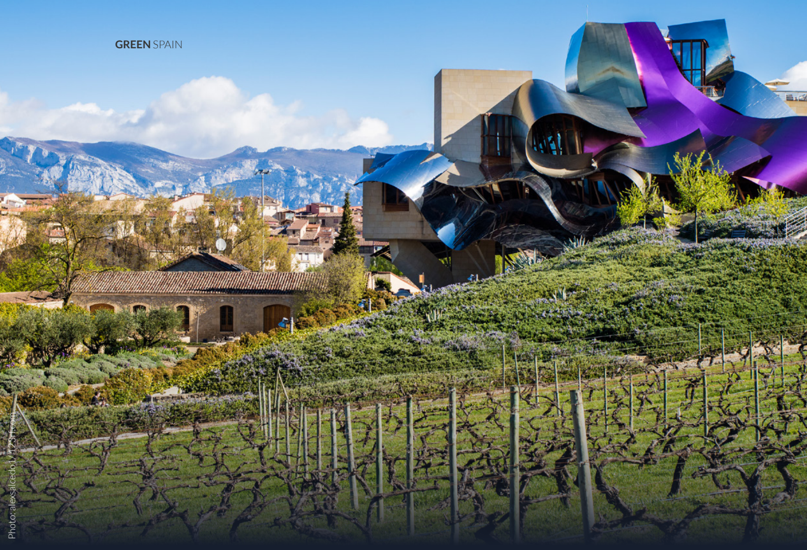
▲ MARQUÉS DE RISCAL WINE-CELLARS ELCIEGO, ÁLAVA
