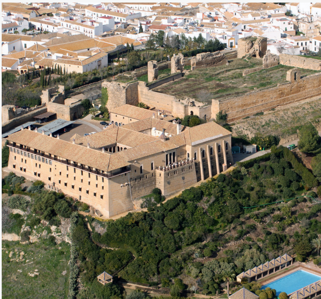
▲ PARADOR DE CARMONA SEVILLA
